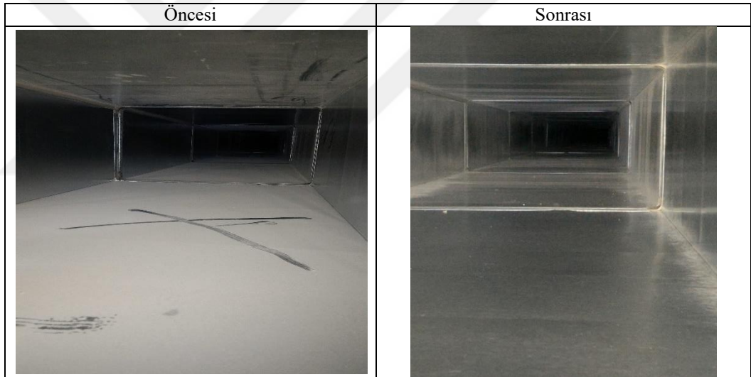
Şekil 10.5. Havalandırma kanalının temizlik öncesi ve sonrası
