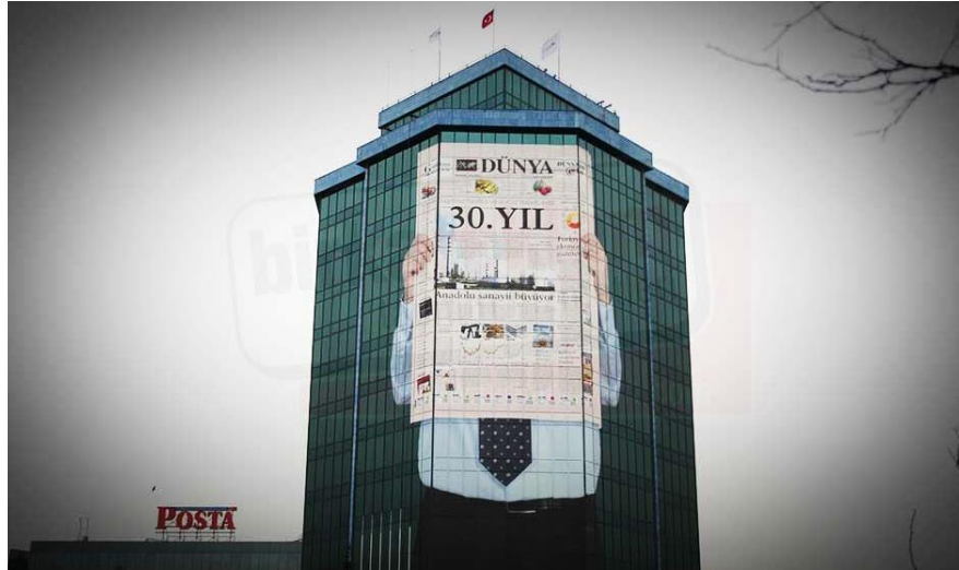
Resim 41: Bina Giydirme (Cam Cephe) reklam uygulaması
