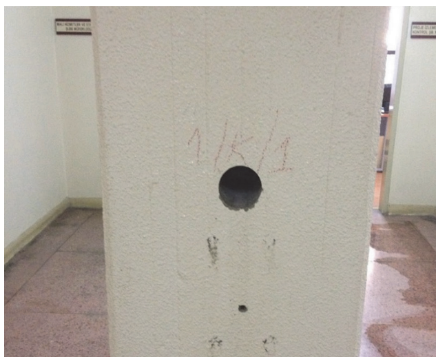
Slika 1. Uzimanje uzoraka betonske jezgre iz konstrukcije bušenjem
